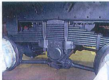
大型車施工例
