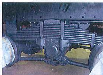
大型車施工例
